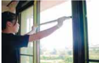
窓ガラスコーティング作業
