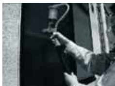
窓ガラス作業状況
