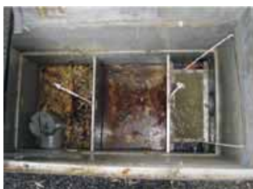
ポンプ 作動前
