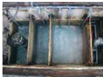
配管施工状況
